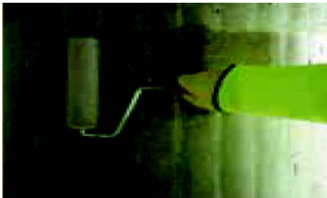
Sau khi chuẩn bị bề mặt, chỉ cần tiến hành lăn keo lên bề mặt bê tông
