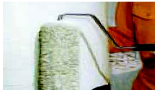
Sau khi keo khô, tiến hành sơn bảo vệ bề mặt tấm FRP
