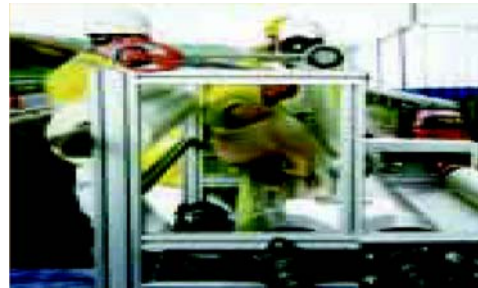
Tấm nhựa vào tấm FRP đến khi bão hòa trước khi dán vào cột
