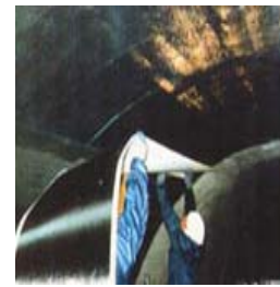
Gia cố đường hầm
