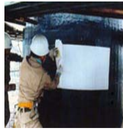
Gia cố ống khói
