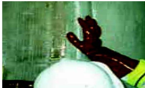
Dán tấm FRP đã tẩm nhựa lên bề mặt bê tông đã được sơn keo
