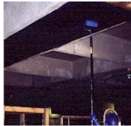
Sửa dầm bằng dán các tấm FRP ở đáy
