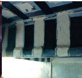
Sửa chữa dầm bằng tấm FRP
